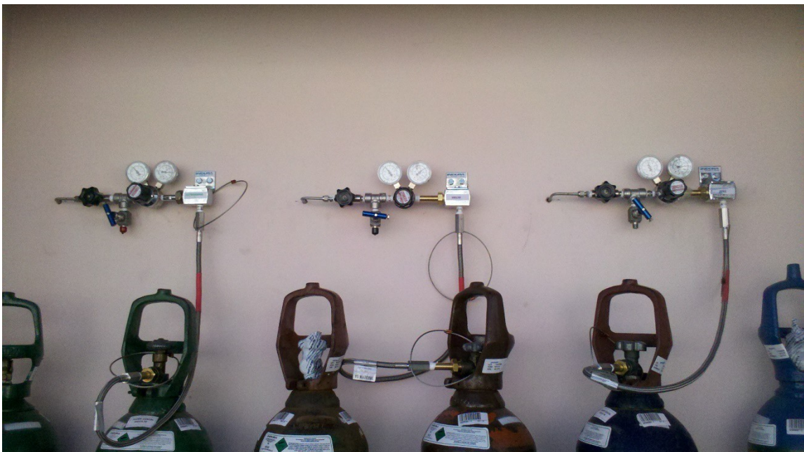
Instalación con dado de acople
