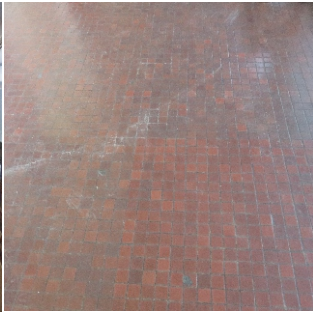
7) Piso del pasillo de Circulación Pública.
