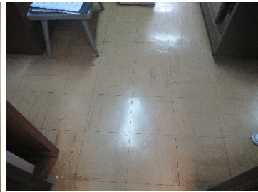
Detalle piso existente interior de las oficinas a ser reemplazados por pisos porcelanatos.
