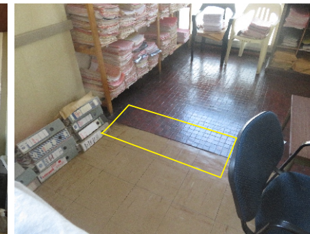
4) Detalle de encuentro de pisos a reemplazar.
